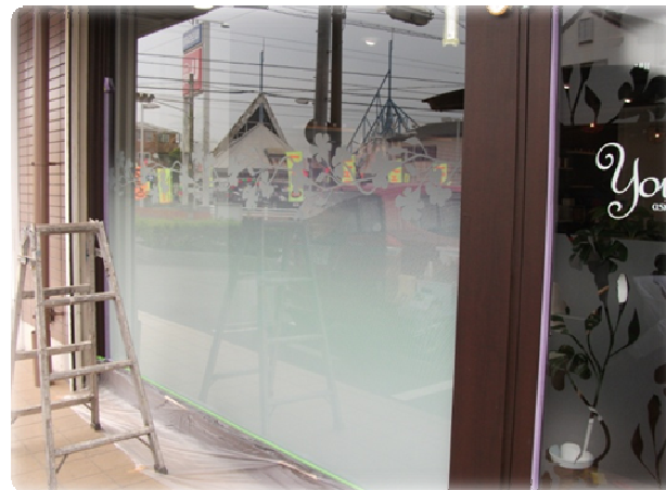
③ 養生 塗料が、ガラス面以外に付着しないよう保護します。
