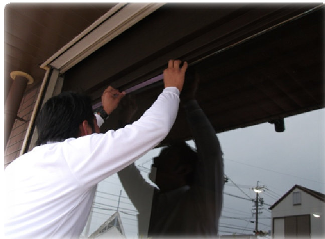
③ 養生 塗料が、ガラス面以外に付着しないよう保護します。
